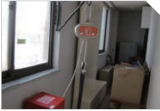
재난대비 양호등급 상태
